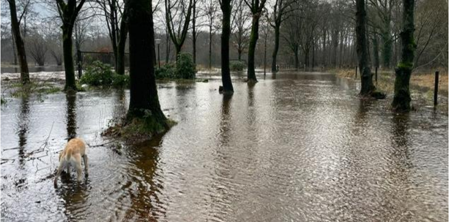
De Reusel met in de verte, de ondergelopen brug van de Buitenman
